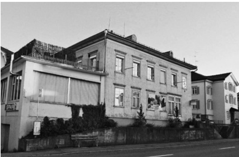
Der SPAR mit Post (links) und die Gemeindeganzlei (rechts) sollen einer neuen Zentrumsüberbauung weichen. Doch die Realisierung wird noch dauern.
