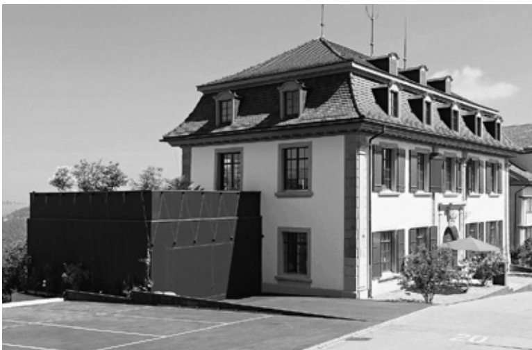
Beispielhaft gelungener Umbau und deshalb mit dem Schweizer Denkmalpreis ausgezeichnet: Das Trogner Zeughaus.
