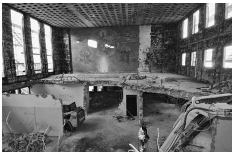
Umbau des Kapellentraktes am Gymnasium Appenzell.
