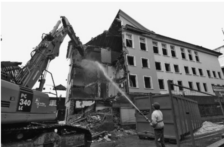
Abbruch des Hotels Krone in Appenzell.
